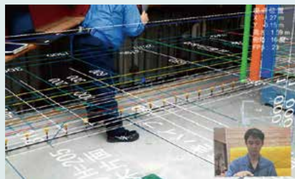
リモート 本社にある PC と、現場の HoloLens を通じて、離れた場所同士での遠隔コミュニケーションが可能です。
