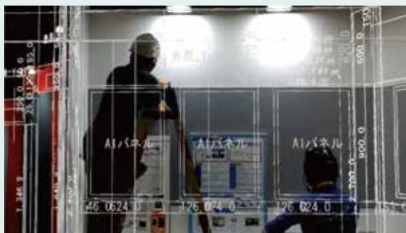
図面実寸投影 CAD 図面や 3D モデルデータを現場に実寸投影します。
