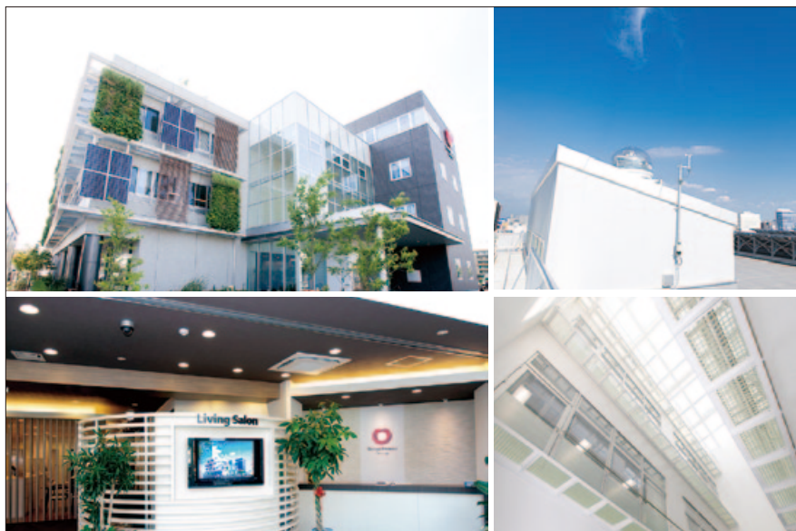
環境配慮型オフィスのモデルでもある岐阜支店の新オフィスは、“環境負荷ゼロ”を目指したさまざまな工夫が施されている
